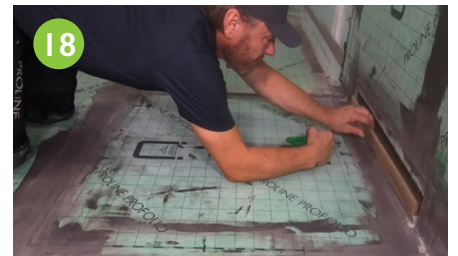
Schutzschutz aus dem Rinnenkörper entfernen.
