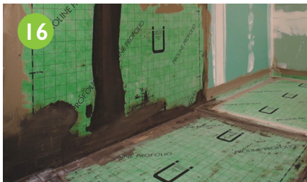
Die kompletten Boden- und Wandflächen müssen gemäß DIN 18534-1 abgedichtet werden.
